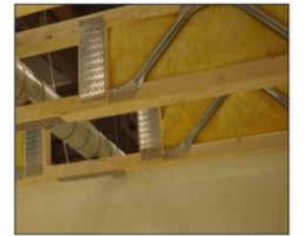
Bjælken kan leveres færdig isoleret fra fabrik. Herved spares arbejde og tid på byggepladsen.
